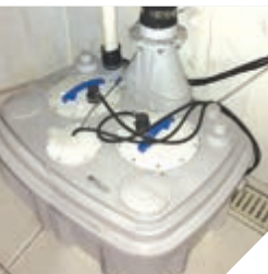
-2 kattaki depoya kurulmuş Sanicubic 2 XL
