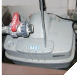
Makine odasına kurulan Santicubic 2 Classic
