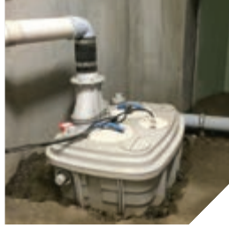
Montajı yapılmış Sanicubic 2 XL
