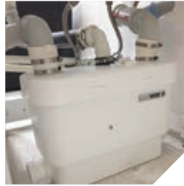
Saç yıkama lavabolarının altına gizlenmiş Sanivite
