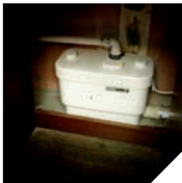
Tezgâhın altına gizlenmiş Sanivite pompa
