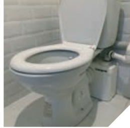
Klozetin arkasına monte edilmiş Sanitop
