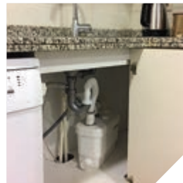
Tezgâhın altına gizlenmiş Sanivite pompa
