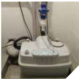
Montajı yapılmış Sanicubic 2 Classic
