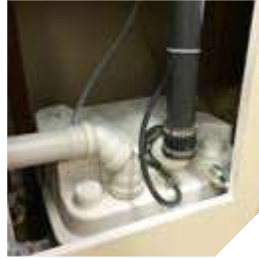
Alçıpan içine gizlenmiş Sanicubic 1 WP
