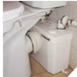
Klozete monte edilmiş Sanitop
